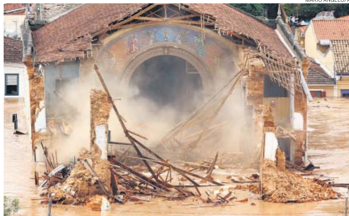
TRAGÉDIA - Igreja ruiu ao ser atingida pelas águas; pelo menos dez prédios tombados já vieram abaixo
